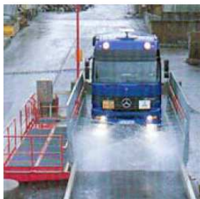
Foto. Sistema lava-ruedas (Fuente: Puertos del Estado)
